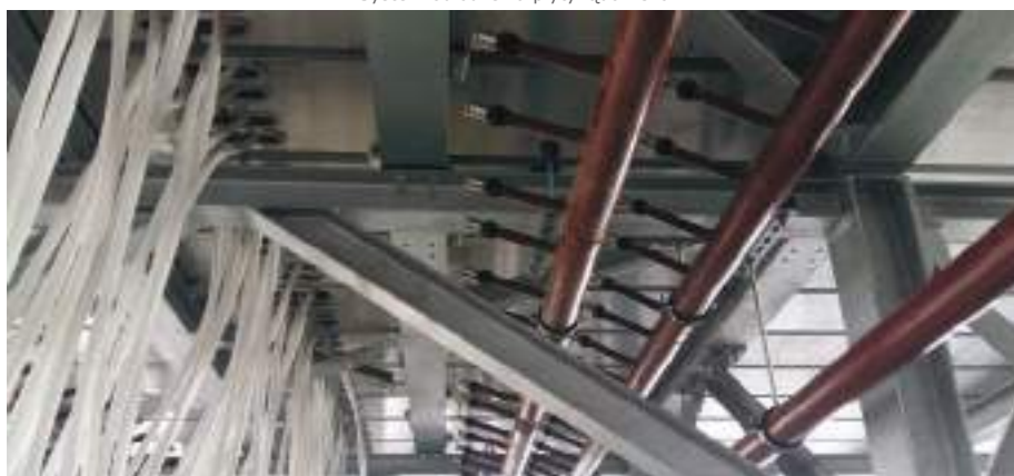
System odlodzenia płyty lądowiska
