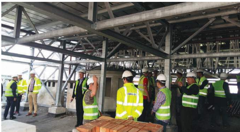
Konstrukcja nośna lotniska
