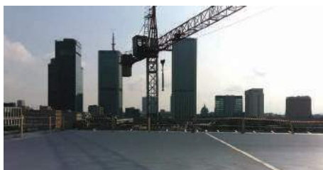
Pokrycie płyty lądowiska z aluminiowych paneli
